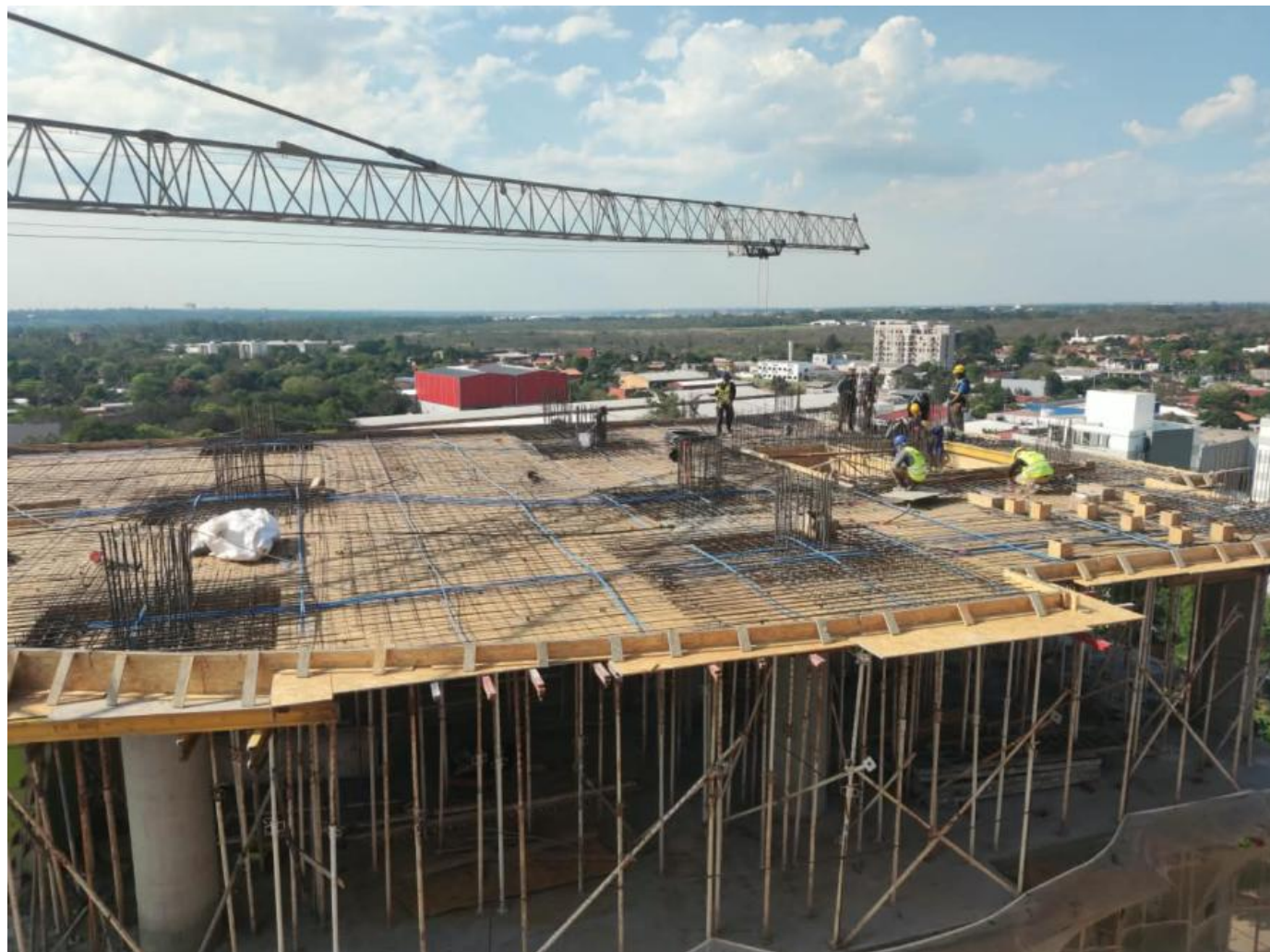
Encofrado y armado losa N9
