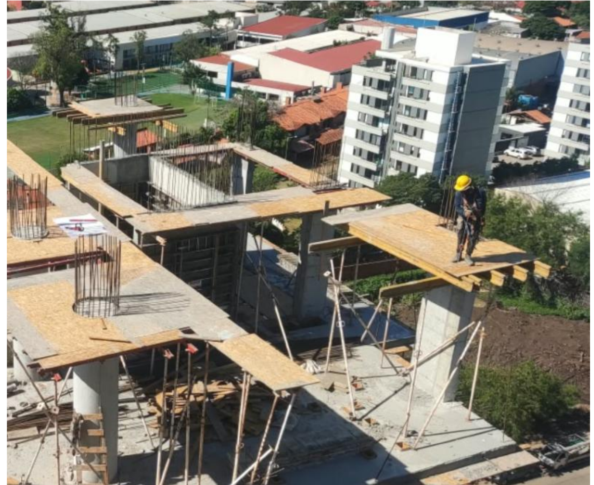
Encofrado de capiteles de losa N10
